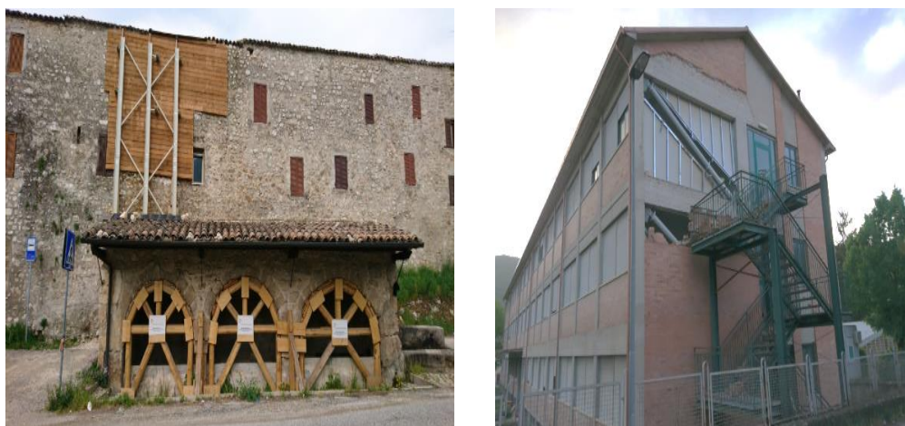
Figura 9. (a) Punerea în siguranță a zidului de incintă precum și a arcadelor de la construcția adiacentă/ (b) Punere în siguranță și contravântuiri la o școală existentă în Norcia
